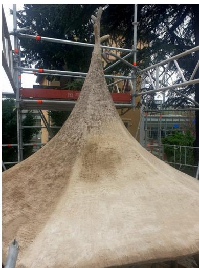
Décapage et reprises du toit du kiosque, avant restauration des rives, puis application d'un produit « reminéralisant » afin de réaliser une protection des ouvrages en ciment.
