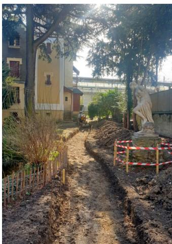
Décapage préalable des allées avant restitution d'un support stable pour permettre la circulation des personnes à mobilité réduite.
