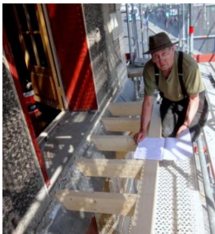
État des pièces de bois constituant le balcon d'origine
