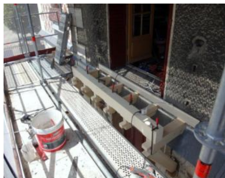
Le support du nouveau balcon est en place
