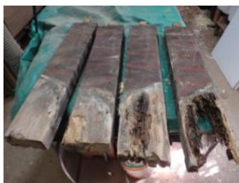
État des pièces de bois constituant le balcon d'origine
