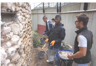
Piochement des joints
