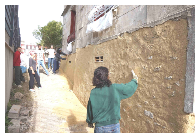
Travaux de finition (brossage)
