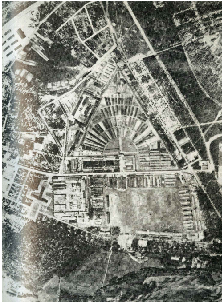
Vue aérienne du camp de Sachsenhausen
