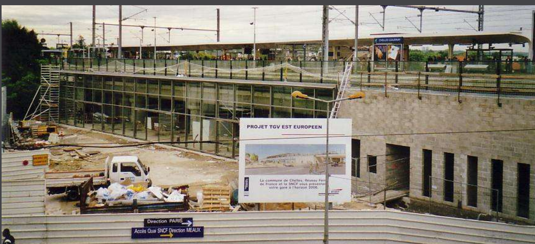
Mai 2006 façade vitrée
