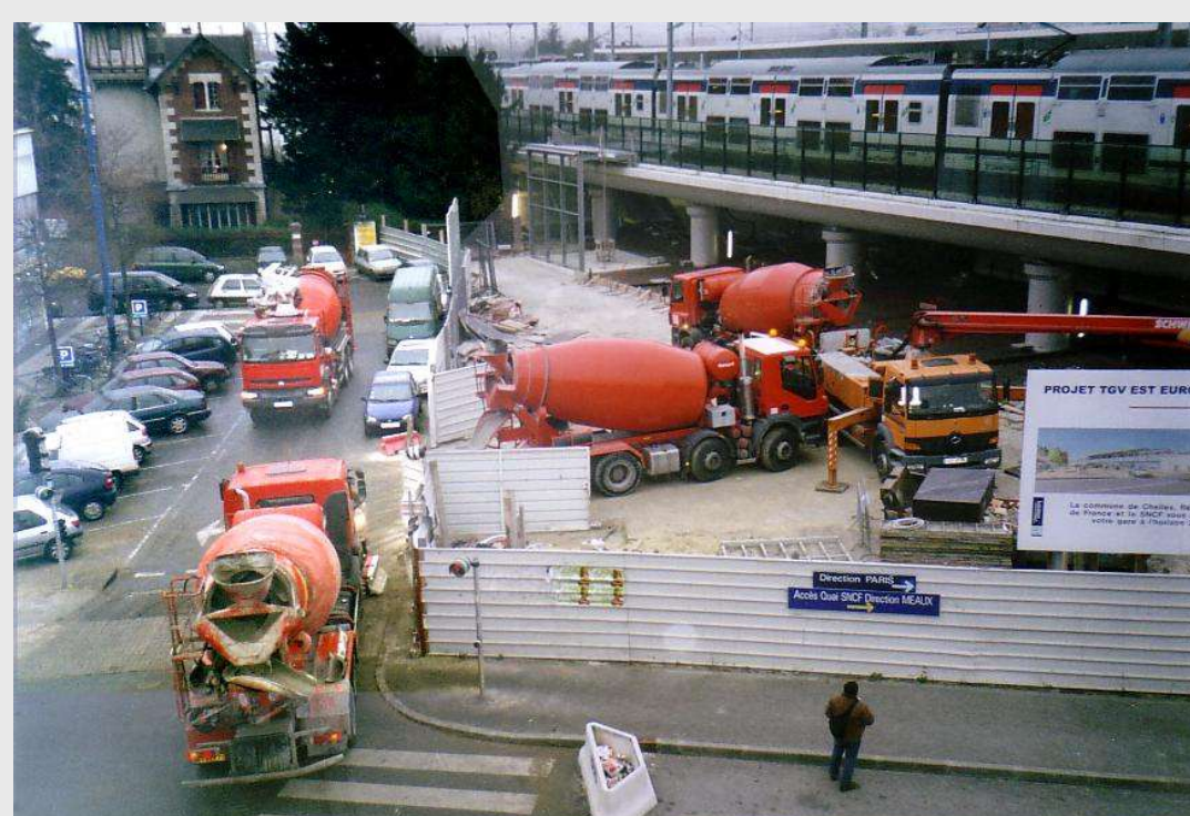
Janvier 2006 : coulage de la dalle Les arbres de la villa Max sont toujours là.
