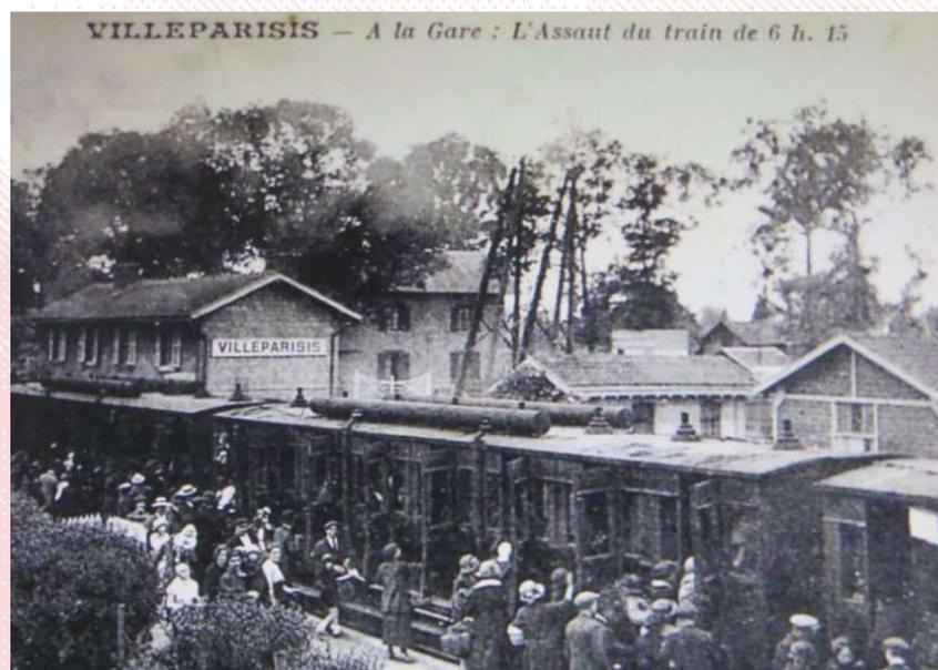
Les tubes sur le toit des voitures sont remplis de gaz pour l'éclairage
