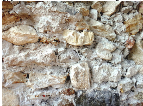
Type de maçonnerie traditionnelle à Chelles
