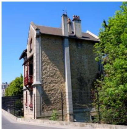
La Villa Max avant les travaux 2019, avec le balcon sud et le conduit de fumées à démolir
